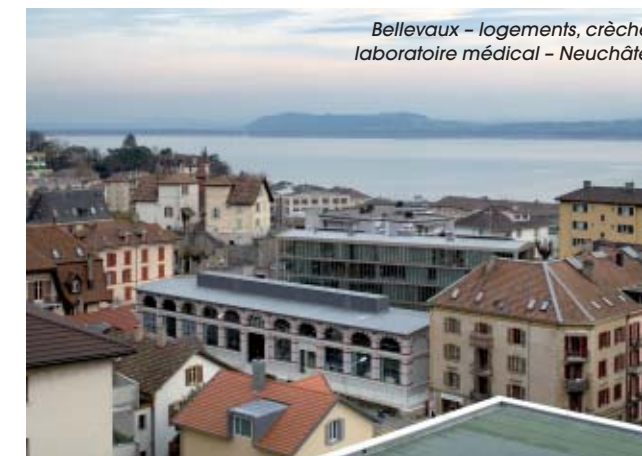
Sur la Forêt – complexe résidentiel de 66 logements – Boudry
